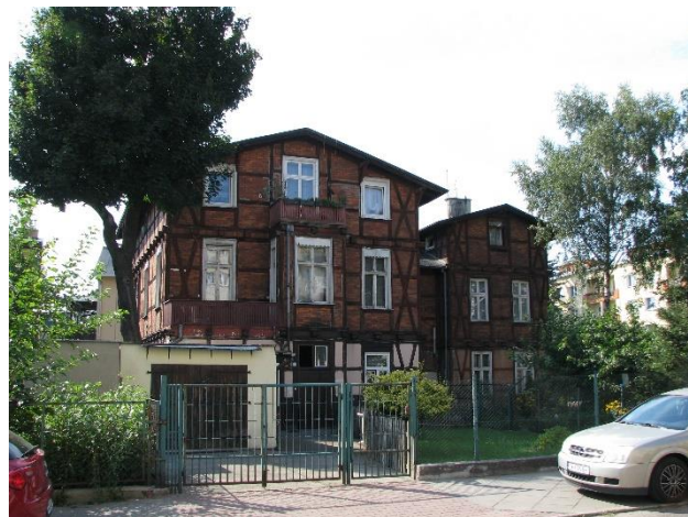
Budynek szkieletowy z współczesnym garażem [ul. Bydgoska 24]
