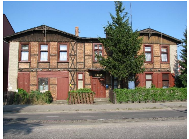
Dom szkieletowy, współczesne naprawy naroży, zachowany detal (okiennice, stolarka) [ul. Szosa Chełmińska 62–64]
