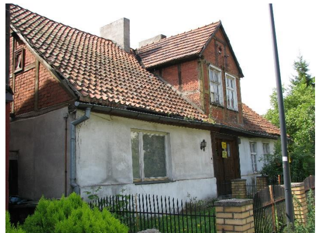
Dom szkieletowy na Winnicy – przeznaczony do rozbiórki [ul. Winnica 24]
