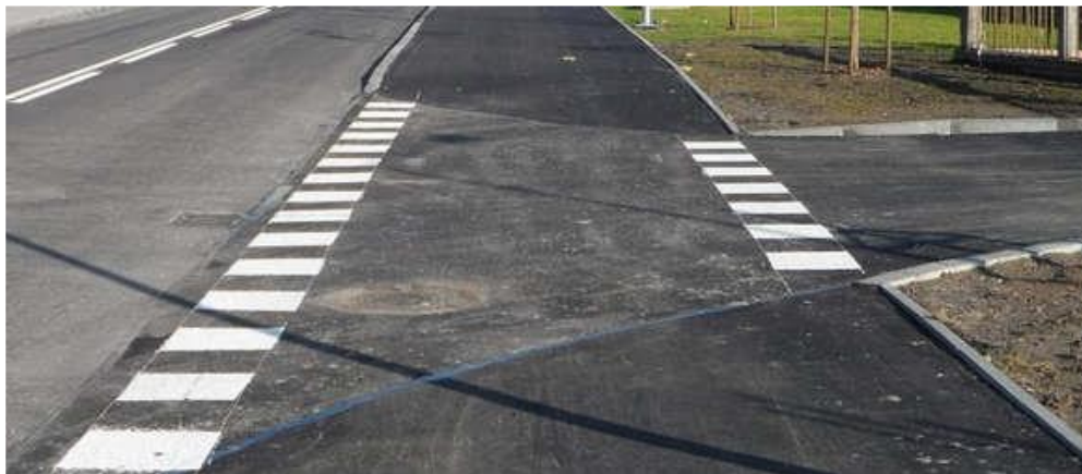
Fot. 1. „Bezszwowe” połączenie nawierzchni drogi rowerowej z nawierzchnią jezdni. Radom.
