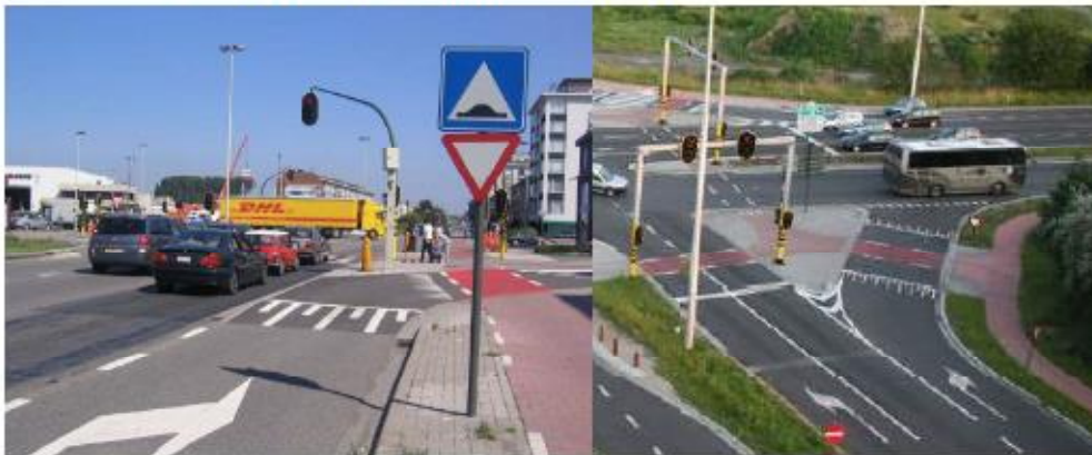
Fot. 2, 3. Przykłady bezpiecznych przejazdów rowerowych przez prawoskręty. Antwerpia.
